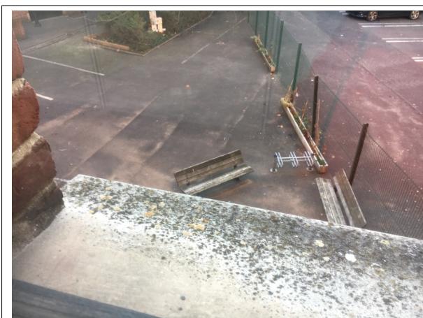
Prélèvement - BB8 : Bâtiments A&B > R+1 & R+2 > Menuiseries Extérieures - Appui de fenêtre en fibres-ciment- (Présence d'amiante)
